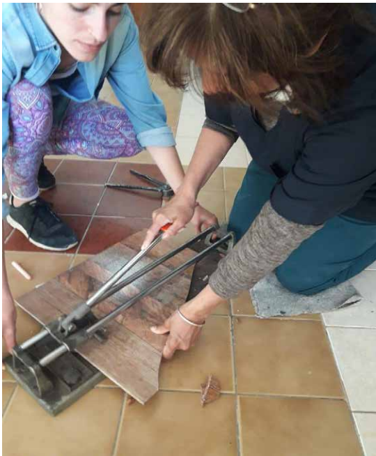
Operadora comunitaria y estudiante de psicología rotante, cortando cerámicos para arreglar el piso.
