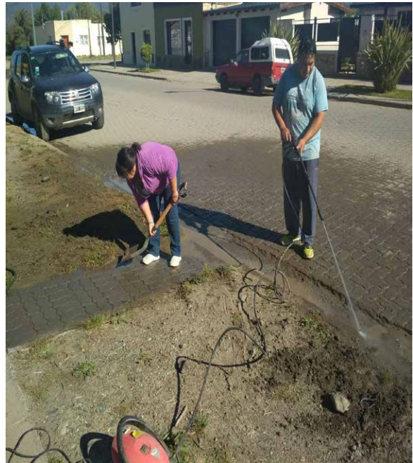
Operador comunitario y emprendedora limpiando la vereda para pintar la necesaria señalización de estacionamiento exclusivo para personas con discapacidad.
